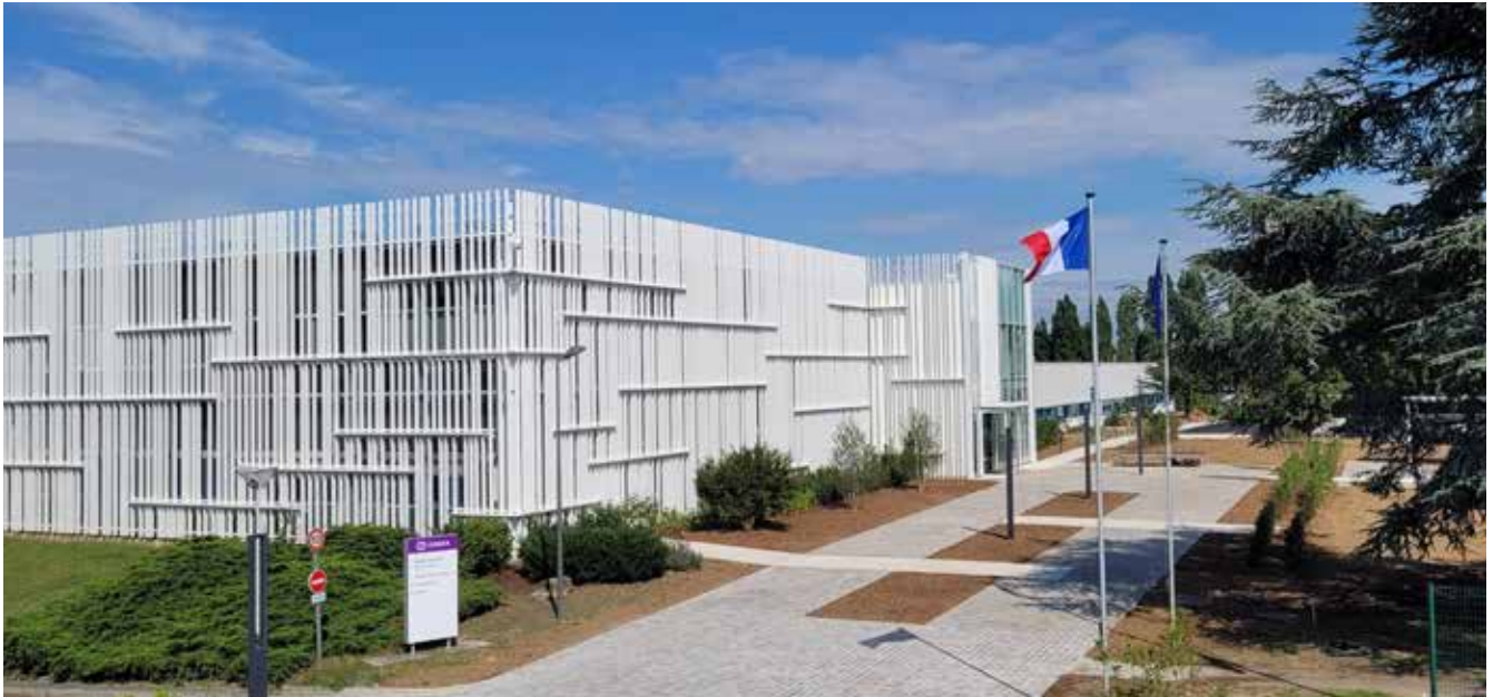
La plupart des solutions technologiques d'Idemia sont imaginées et fabriquées ici, sur le site osnysois réinventé par le cabinet d'architecture Viguier.
