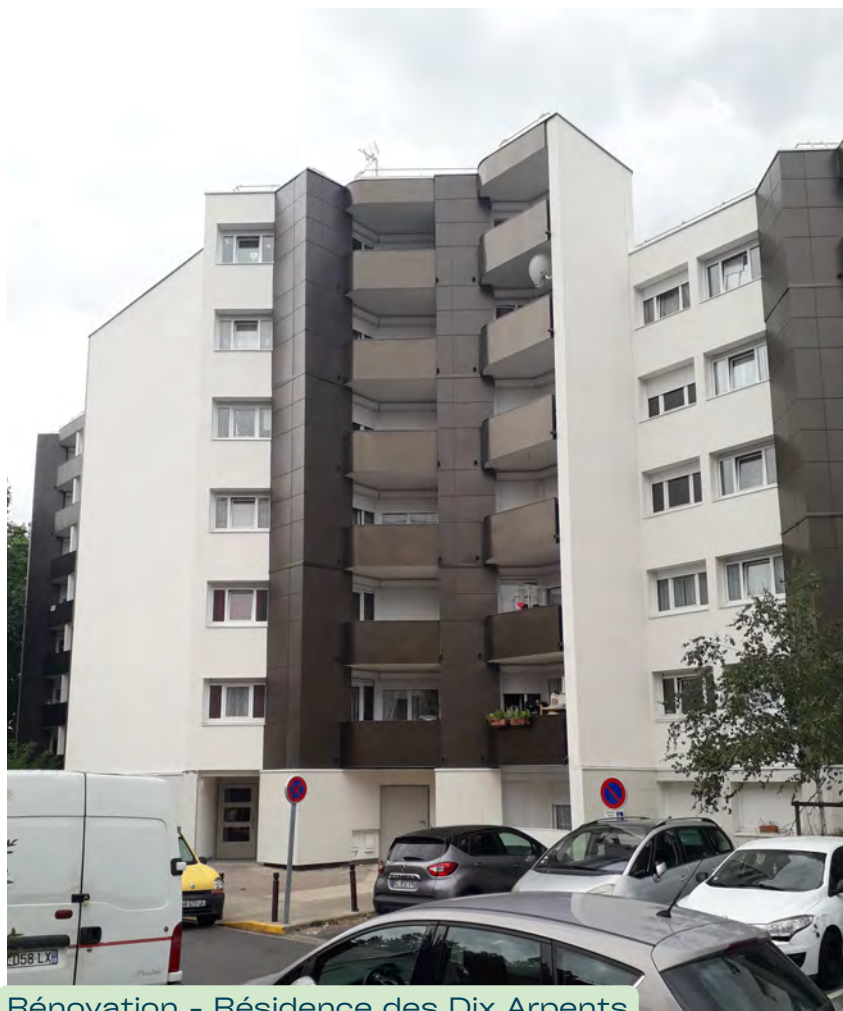
Rénovation - Résidence des Dix Arpents
